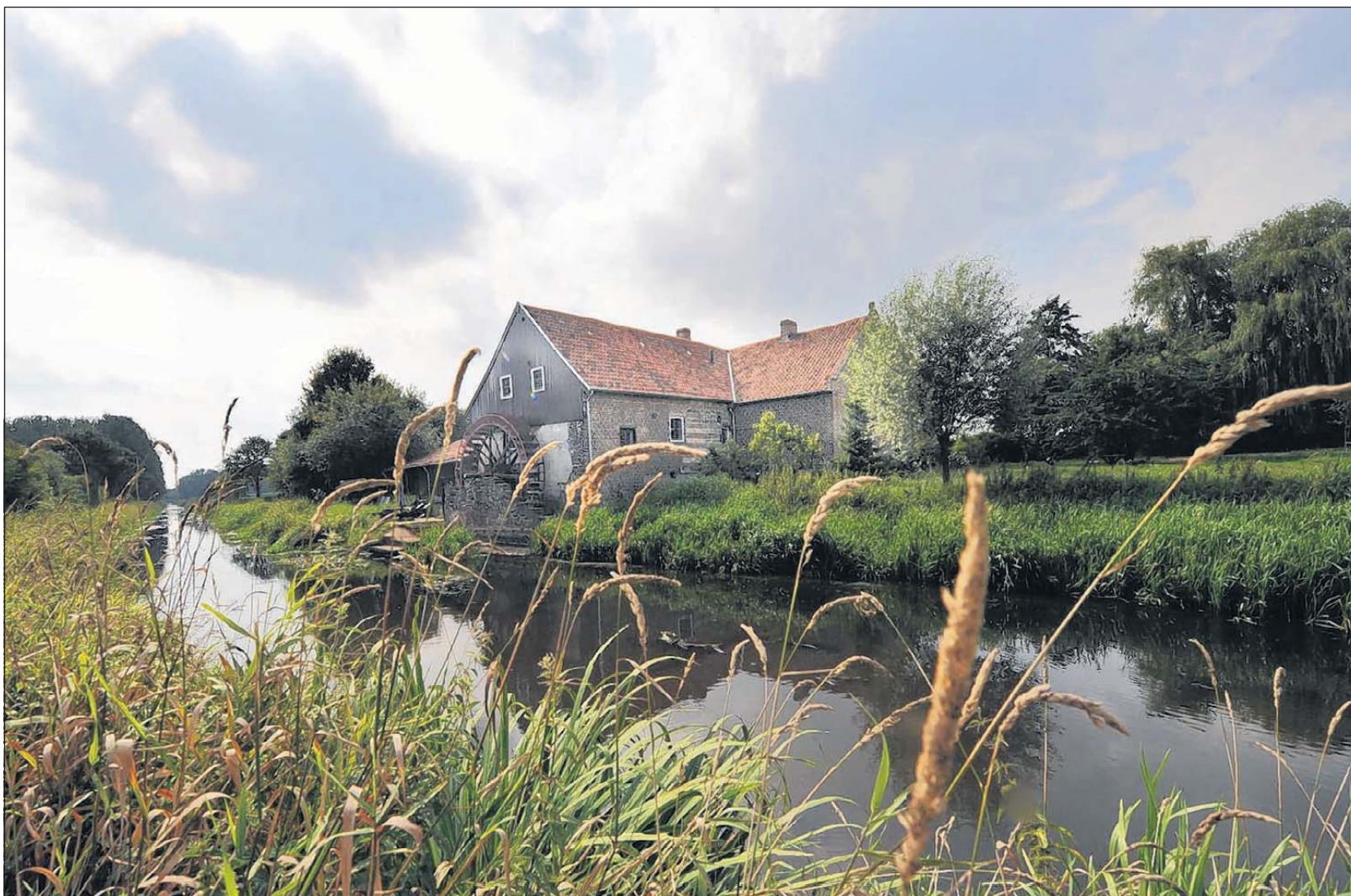
De grote constructiewerkzaamheden aan de Uffelse molen zijn zo goed als afgerond.
